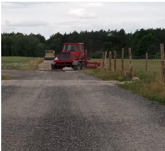
Równanie i wałowanie drogi w miejscowości Sendeń Mały, gmina Łąck.
