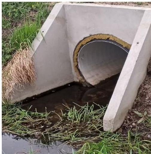
Wymiana przepustu w miejscowości Antoninów, gmina Łąck.
